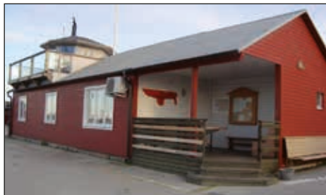
Dagens Klubbhuset med tornet som Royal Rabbits besättning byggt under Mats Forsman ledning.
